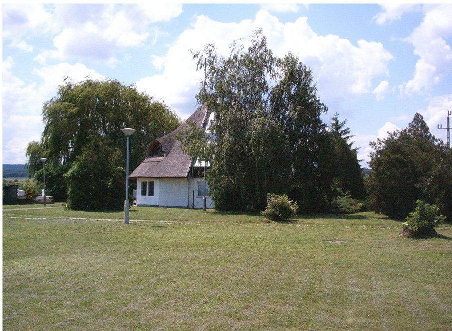
a Hidrometeorológiai állomás épülete Fertőrákoson
